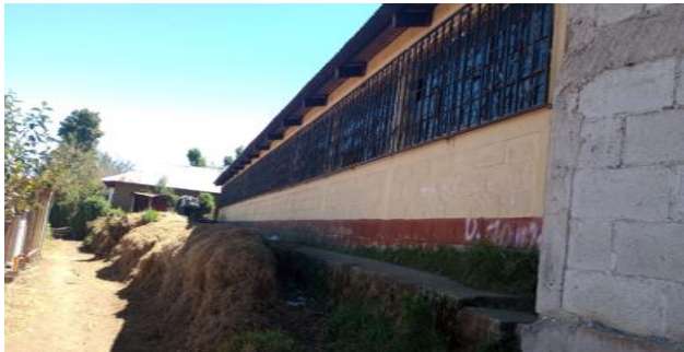
Foto 5: pintura en muros exteriores e interiores
