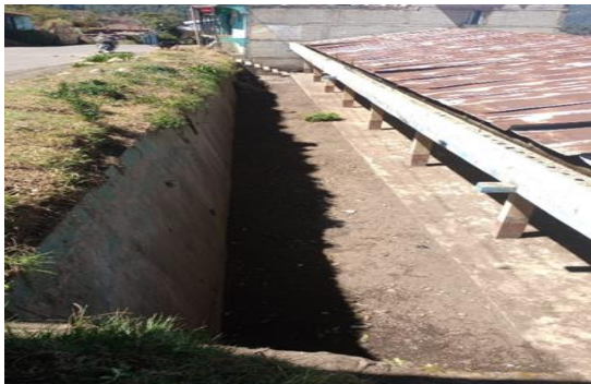
Foto 3: sustitución de canal metal
