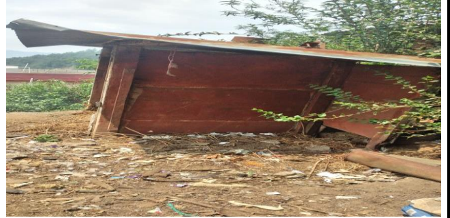
Foto 2: sustitución de pared de baños y puertas de metal
